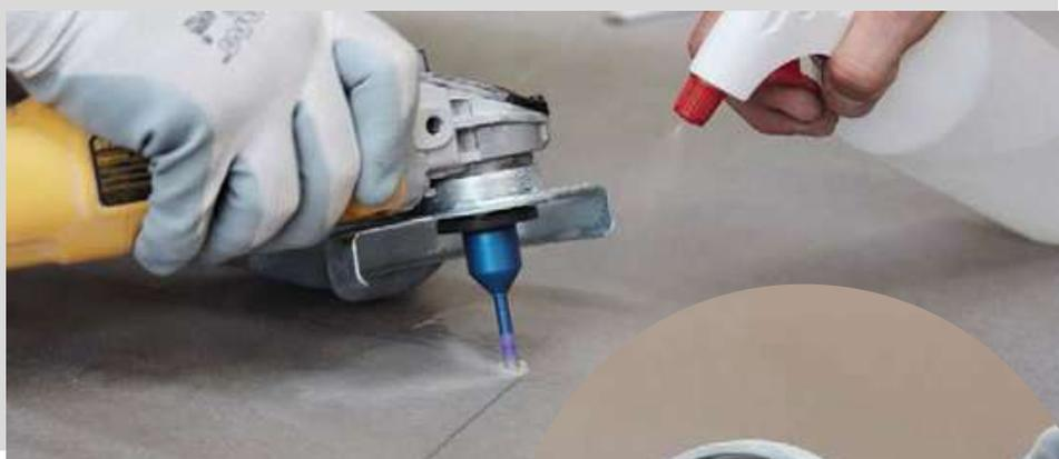
Disegnate le dimensioni del foro, usare un trapano non battente o una smerigliatrice con punta o fresa diamantata (6-10 mm), mantenendo costantemente raffreddato l'utensile.
